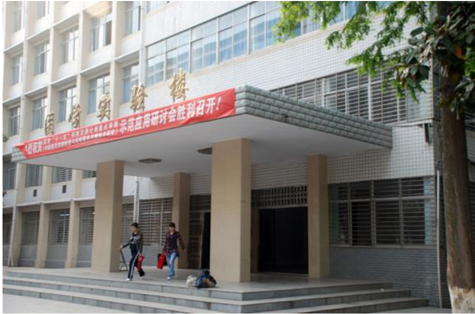
▲医学基础实训楼
